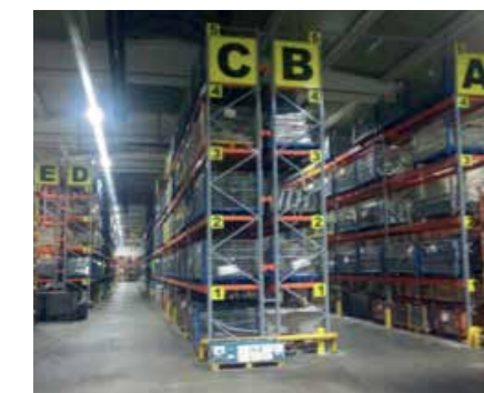
BGO mamul ambarı raf yapım aşaması
